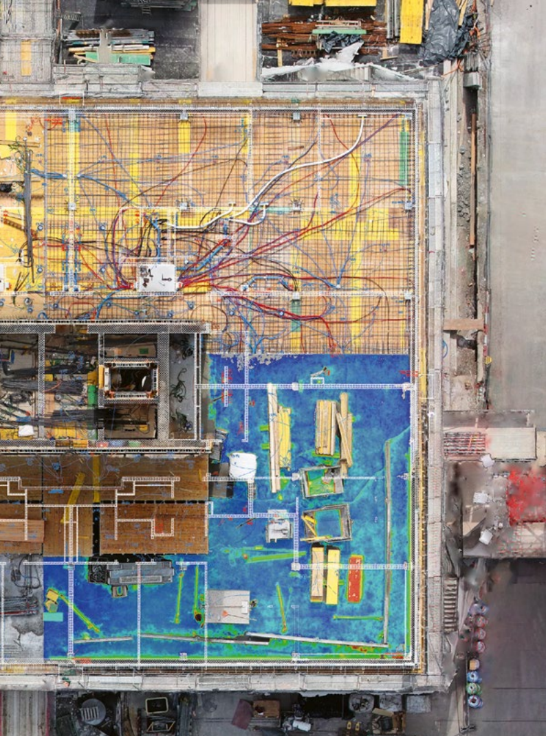
Zuschnitt Orthophoto (Höhenmodell, Grundriss- und Einlagenkontrolle) und Planüberlagerung.
